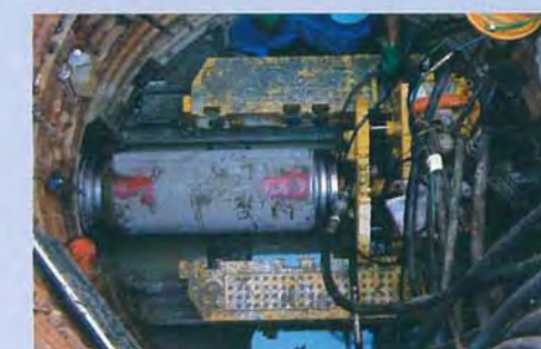
No.3ヒューム管1m短管推進状況
