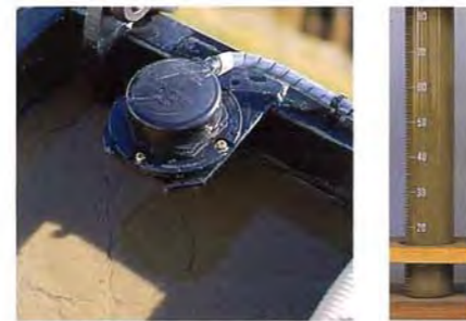
濁水+PAC 高分子凝集剤「サークリーン」を注入
